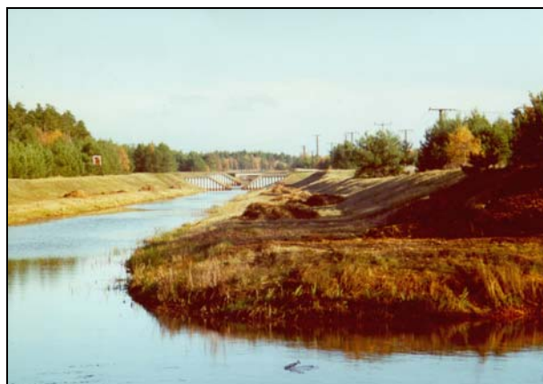
Folienabgedichteter, umverlegter Abschnitt des Weißen Schöps: ein vorläufig als künstlich ausgewiesener Wasserkörper (Foto: LfUG)
