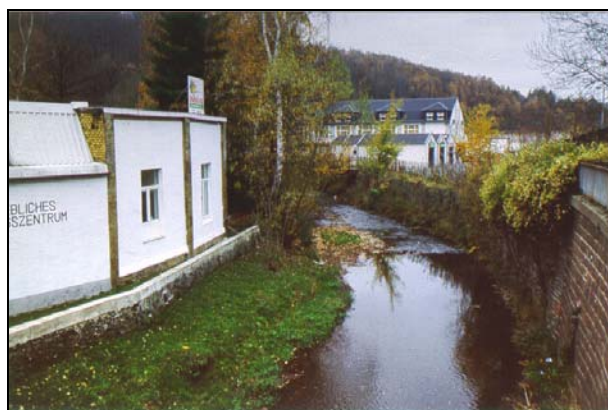
Stark ausgebauter Gewässerabschnitt der Würschnitz im Siedlungsbereich von Harthau: ein vorläufig als erheblich verändert ausgewiesener Wasserkörper (Foto: LfUG)
