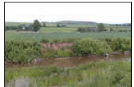
Abb. 8-10: Lebendbuhnen zum Schutz einer gewässerparallel verlaufenden Gasleitung sichern das Ufer vor weiterer Seitenerosion und verbessern gleichzeitig die Gewässerstruktur. Die Buhnen erhöhen die Strömungs- und Substratdiversität sowie Tiefen- und Breitenvarianz. Mit fortschreitender Vegetationsentwicklung werden sich aus den Buhnen standortgerechte Gehölzbestände entwickeln, die wiederum die Uferstruktur aufwerten, das Gewässer beschatten und regulierend auf die Wassertemperatur einwirken. Zwischen den Buhnen bleiben Uferabschnitte der Sukzession überlassen. Die ökologisch wertvollen Steilufer bleiben bis zur natürlichen Böschungsabflachung erhalten. In Gewässerabschnitten, in denen keine Infrastruktureinrichtungen, Grundstücksgrenzen oder Ähnliches zu schützen sind, wird der Lungwitzbach der eigendynamischen Entwicklung überlassen. (Fotos: Plan T - Planungsgruppe Landschaft und Umwelt, Radebeul)
