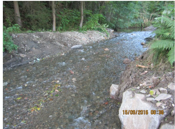
Wehr und unterwasserseitiger Gewässeranschluss vor Rückbau
