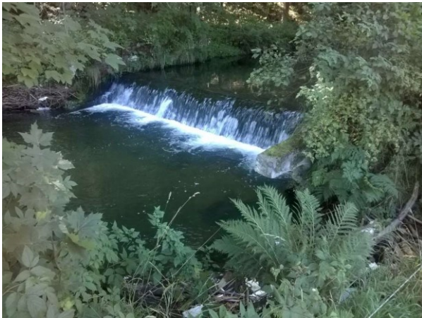
Wehrbestand vor Rückbau
