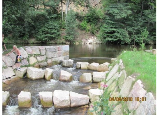
Ausstieg ins Wehroberwasser mit konvexer gekrümmter Tauchwand
