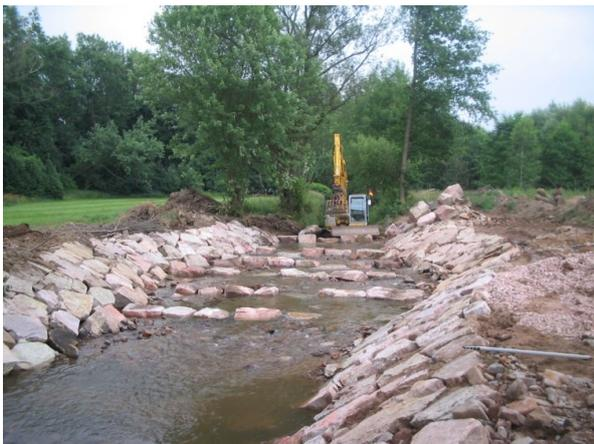
Beseitigung von Gefällestopfen (hier am Standort der ehem. Betonplattenfurt) durch Errichtung einer Riegelrampe sowie Sicherung der Ufer durch begrünten Blocksatz ...
