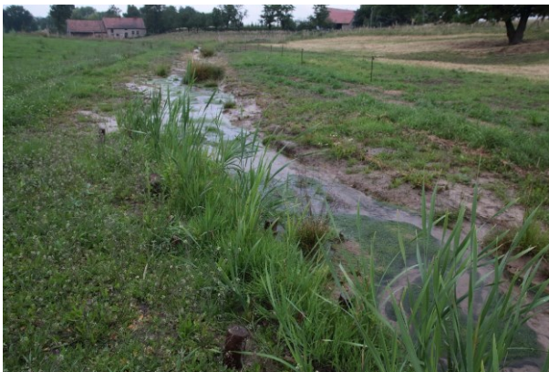
Gewässerabschnitt direkt nach Realisierung im April 2014
