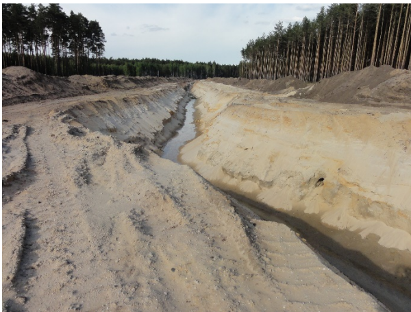
26.05.2012 Beginn der Bauarbeiten zur Neubautrasse
