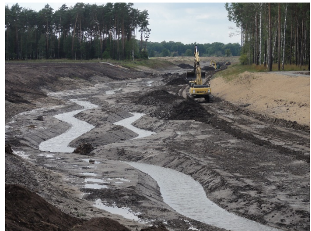
17.09.2013 Formung Gewässer nahe Vogelteich
