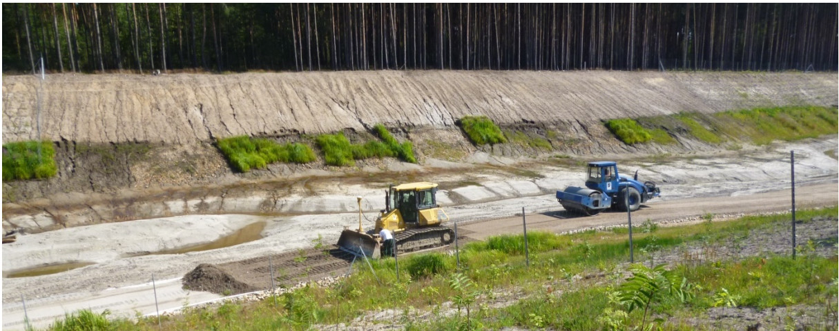
03.06.2013 Erosionssicherungen an Böschungen
