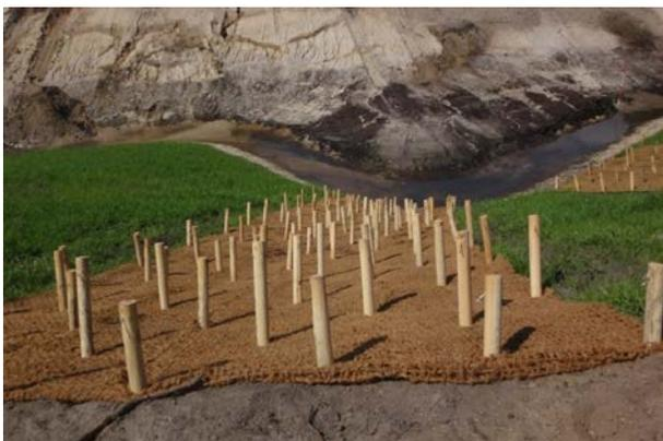
Erosionssicherungen im Bereich einer angetroffenen Störungszone
