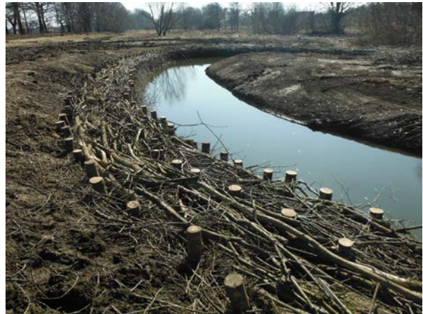
Gewässerabschnitt direkt nach Maßnahmendurchführung 05.03.2013 Sedimententnahme, ingenieurbioologische Ufersicherung)
