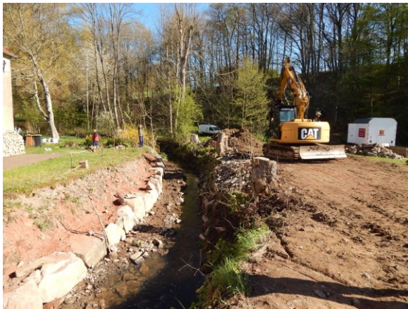
Bauzustand - Mauer wird in Böschung umgelegt
