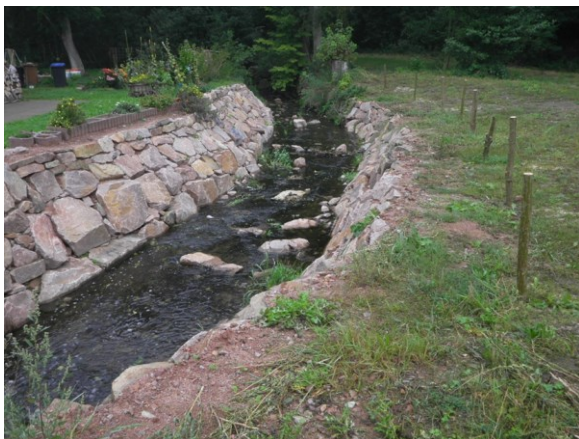
Zustand nachher - Böschung mit Natursteinen und durchgängige Sohle, Weidensetzstangen
