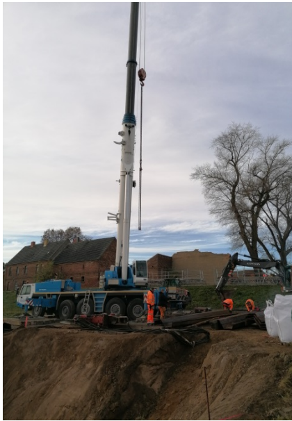
Abb.3 bis 6 Errichtung Spundwandkasten und Verlegung Entnahmetopf
