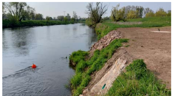
Abb.8: Fertigstellung und Begrünung
