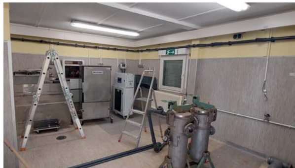
Abb.9 und 10: Sanierung Fußboden und Erneuerung Muldering- und Abwasserleitung im Messcontainer
