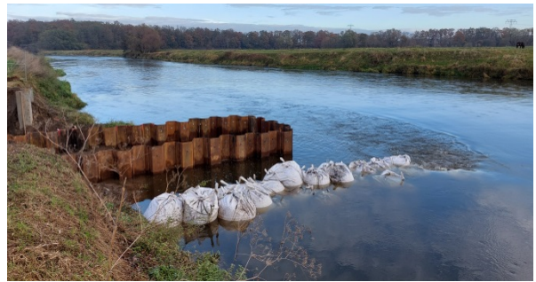
Abb.2: Spundwandkasten mit Bigpacks
