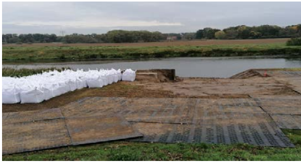
Abb.1 Vorbereitung der Baustelle Oktober 2022
