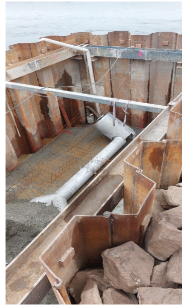
Abb.2: Spundwandkasten mit Bigpacks
