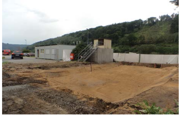
Abb.2: Baubeginn im Oktober 2017
