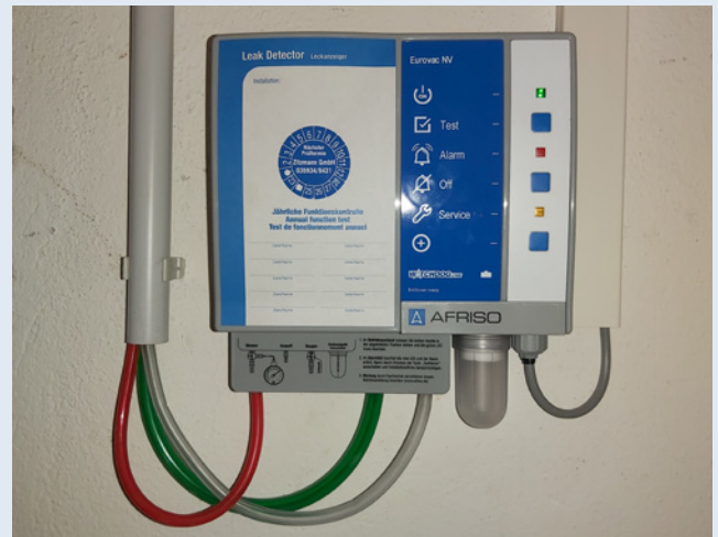
Bild 3: Leckageüberwachung
