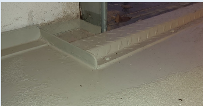
Bild 1: Bodenbeschichtung und Aufkantung zur Errichtung einer Abfüllfläche
