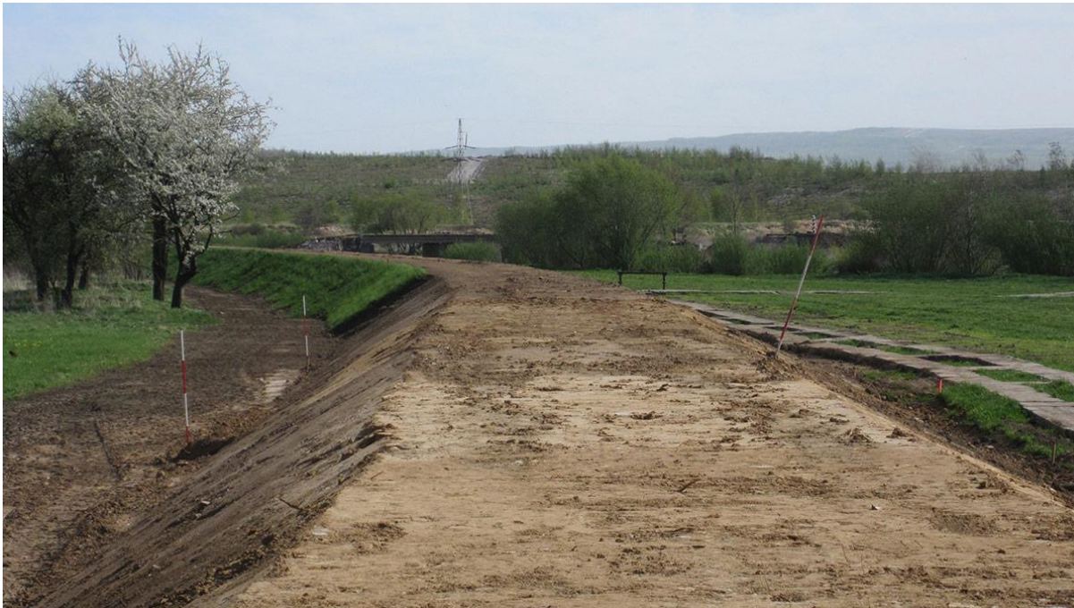
Bild : Deichbau an der Neiße
