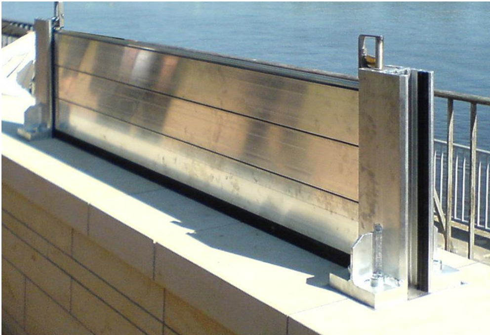
Bild: Mobiles HWS-Element in Dresden
