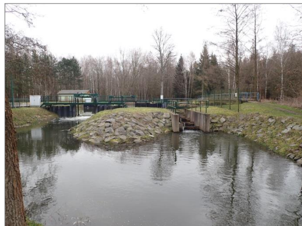
Abbildung 3.6: Schützenwehr und FAA UW (Kleine Röder) (Aufgenommen am: 27.09.2019)
