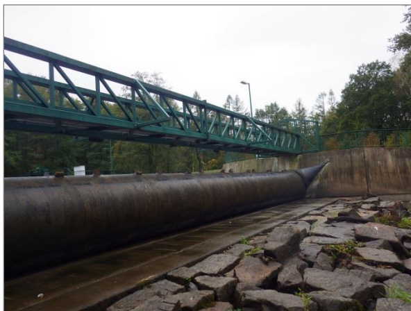
Abbildung 3.5: Schlauchwehr OW Große Röder (Aufgenommen am: 27.09.2019)
