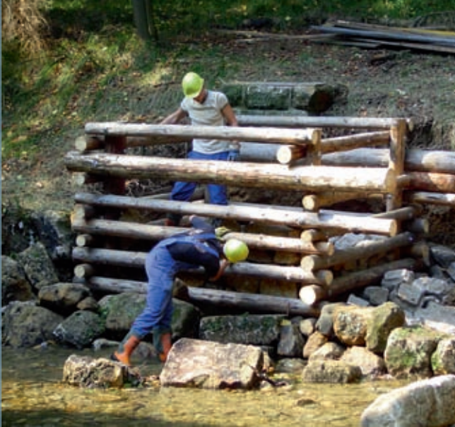
Azubis beim Bau einer Ufersicherung
