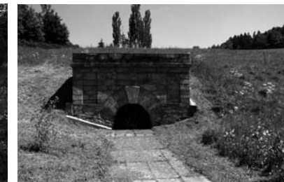
Röschenkopf (Mundloch eines Stollens)
