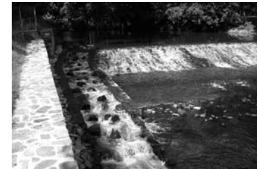
Abb. 12: fertig gestellte FAA
