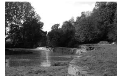
Abb. 14: Schlossmühlenwehr vor Umbau
