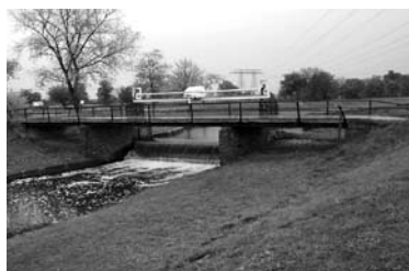
Abb. 22: Köhlerwehr vor Umbau
