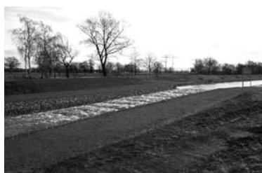
Abb. 23: fertig gestellte FAA
