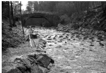
Abb. 9: fertig gestellte FAA
