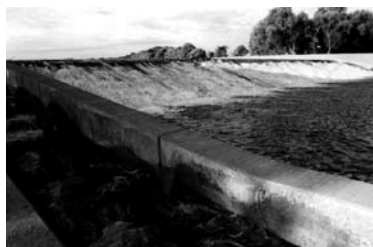
Abb. 21: Wehr mit FAA nach Umbau
