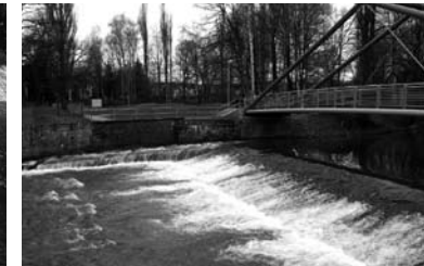
Abb. 13: Wehr mit FAA nach Umbau
