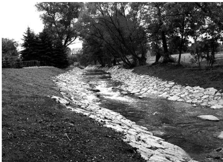
Raue Rampe im Bereich eines ehemaligen Wehres
