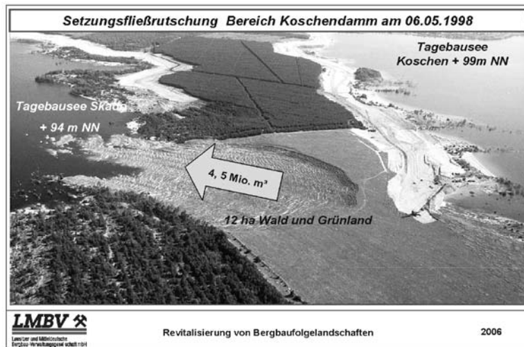
Abb. 8: Setzungsfließrutschung am Kippendam zwischen den Restlöchern der Tagebaue Skado und Koschen
