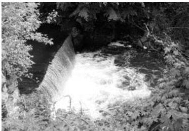
Abb. 6: Sohlabsturz vor Umbau
