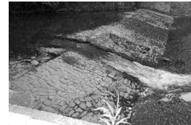
Abb. 10: Wehr vor Umbau
