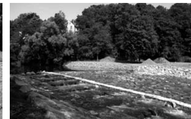
Abb. 17: fertig gestellte FAA
