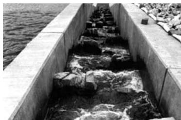
Abb. 19: FAA nach Umbau
