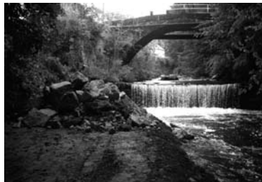
Abb. 7: Sohlabsturz mit Baustraße
