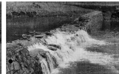
Abb. 15: beschädigter Wehrrücken
