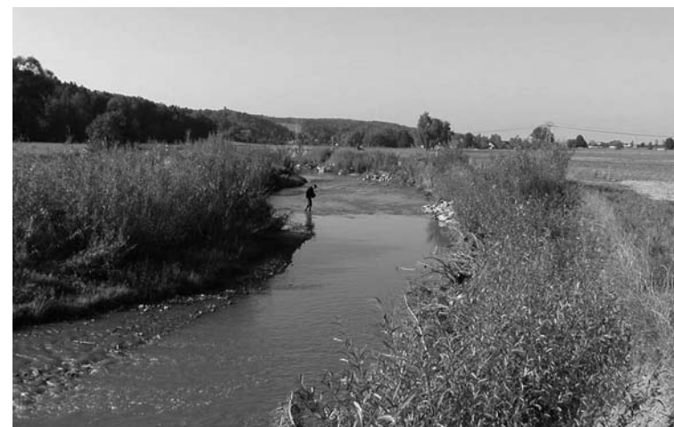
Lungwitzbach wenige Wochen nach Realisierung der ingenieurb biologischen Bauweisen (gleicher Standpunkt wie vorheriges Bild)
