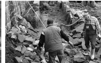
Abb. 11: Bau der FAA
