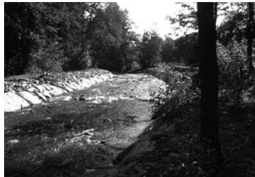
Abb. 5: rückgebautes Wehr in Müglitz September 2005
