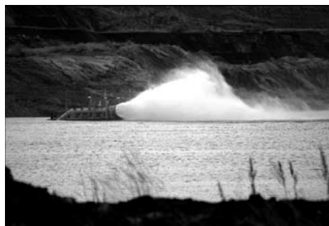
Abb. 19: Flutungsanlage im Tagebau Berzdorf
