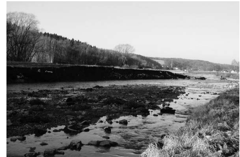
Ein Abschnitt am Lungwitzbach unmittelbar nach dem Hochwasser 2002
