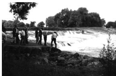
Abb. 18: Muldewehr Kollau vor Umbau
