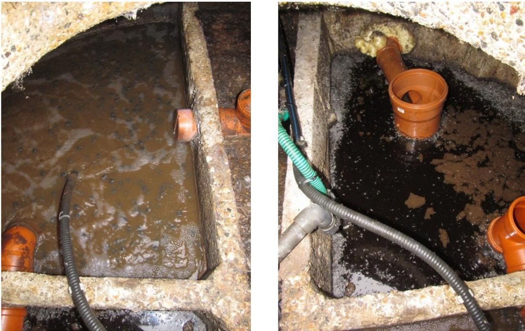
**Abbildung 6-37: Fehlerhafte Nachrüstung und mangelhafter baulicher Zustand einer KKA**
