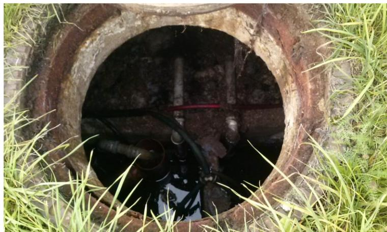
**Abbildung 6-38: Sichtbarer Überstau durch Ablagerungen auf der Trennwand**
