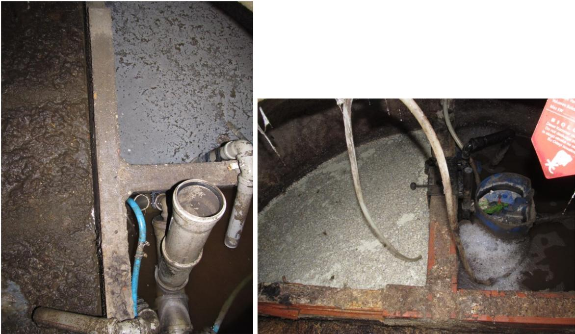
**Abbildung 6-42: Verfärbungen des Abwassers in Kleinkläranlagen mit Betriebsproblemen**
