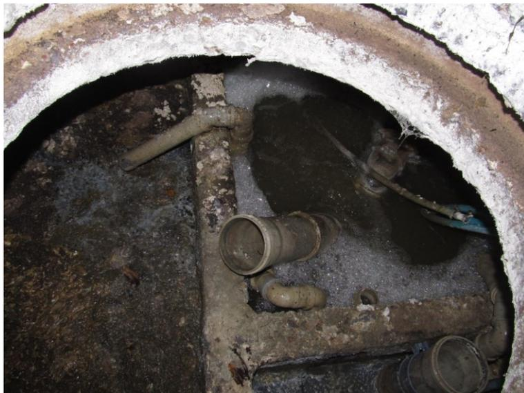
**Abbildung 6-41: Korrosionserscheinungen durch mangelhafte Be- und Entlüftung der KKA**
