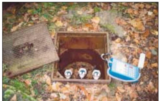
Abb. 2.7: Grundwassermessstelle 1/95 am Großen Zschand
