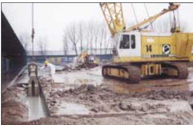
Abb. 5.4: Herstellung des Schlitzes der Dichtwand
