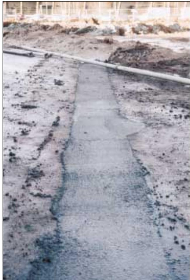
Abb. 5.5: Fertige Dichtwand zur Einkapselung des Schadensherdes
