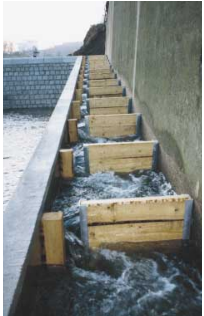
Abb. 159: Aus Platzmangel auf städtischem Gebiet wurde hier eine technische Lösung zur Wiederherstellung der Durchgängigkeit gewählt.
