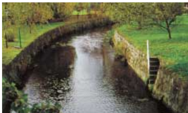
Abb. 29: Massiver Uferverbau beeinträchtigt die Gewässerstruktur der Wesenitz
