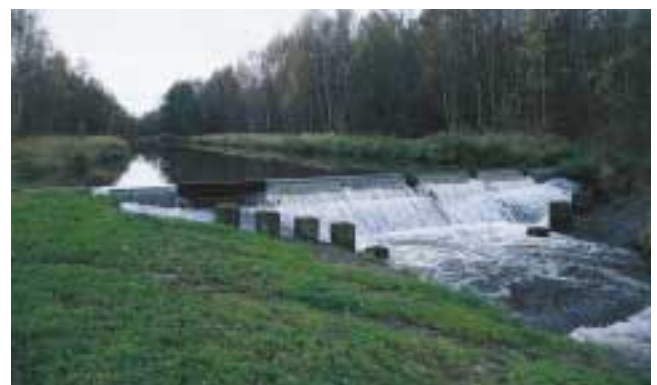
Abb. 146: Derartige Querbauwerke können von Wanderfischen nicht mehr passiert werden – ein Beispiel an der Pleiße bei Stöhma.
