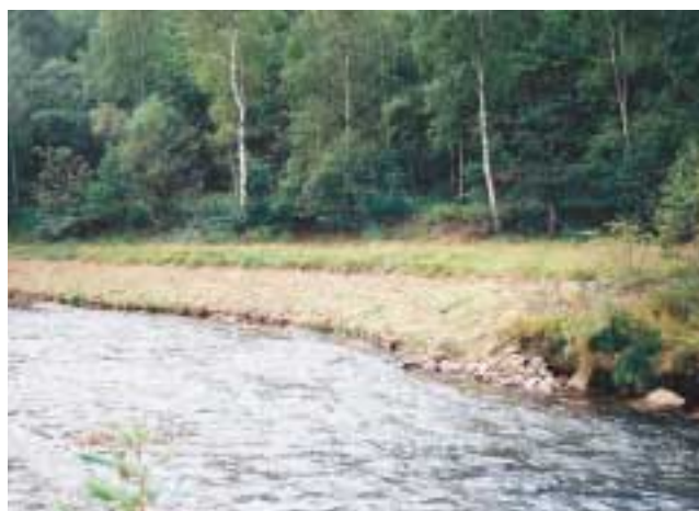
Abb. 163: Die Uferböschung nach der Baumaßnahme.
