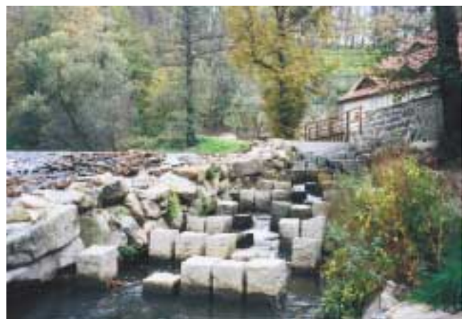
Abb. 154: Bei grobem Sohlensubstrat und geringer Fließgeschwindigkeit in Sohlennähe können auch leistungsschwächere und kleinere Tierarten die Schlitzpässe durchwandern.
