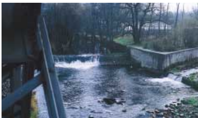
Abb. 95: Im Lauf der Flöha befinden sich 48 Querbauwerke.
