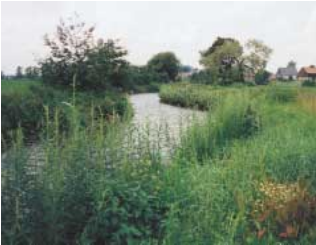
Abb. 165: Auch dieses Ufer bei Pfaffenhain ist durch Faschinen befestigt. Die eingebauten Faschinen wurden mit Mutterboden angefüllt und mit Grassamen besät, so dass sich ein bewachsener und stabiler Böschungsbe- reich entwickelt. Aufnahme: Juli 1997.
