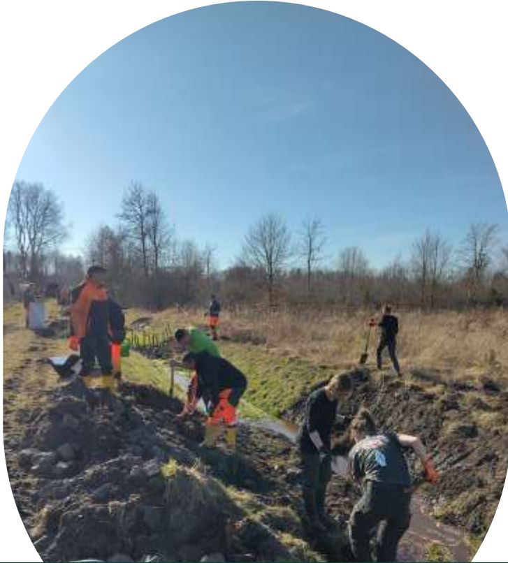
Bauseminar am Gertiggraben in Niesky, März 2025
