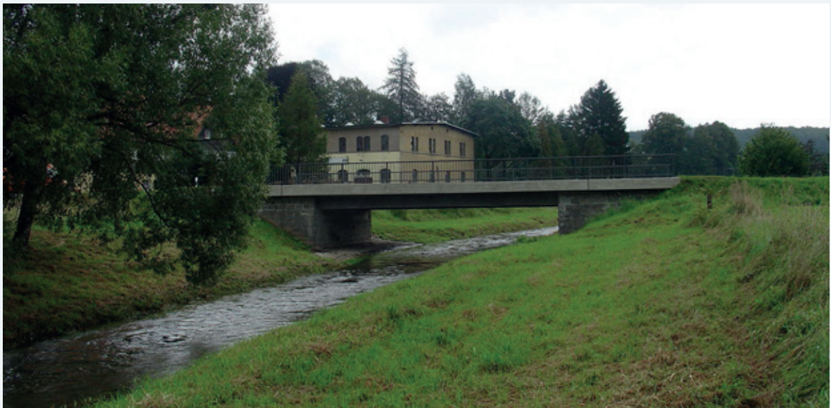
Abbildung 9-43: Vorhandenes Brückenbauwerk bis August 2010 (Foto: SBA Bautzen)
