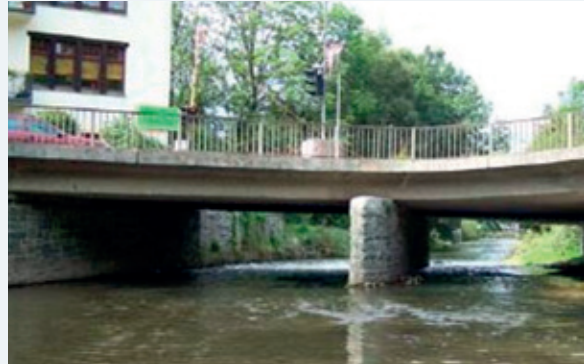
Straßenbrücke Klaffenbacher Straße
