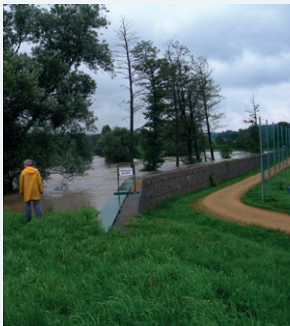
Abbildung 9-9: Kontrolle der Hochwasserschutzanlagen am 07.08.2010, nachmittags (Foto: LDS)
