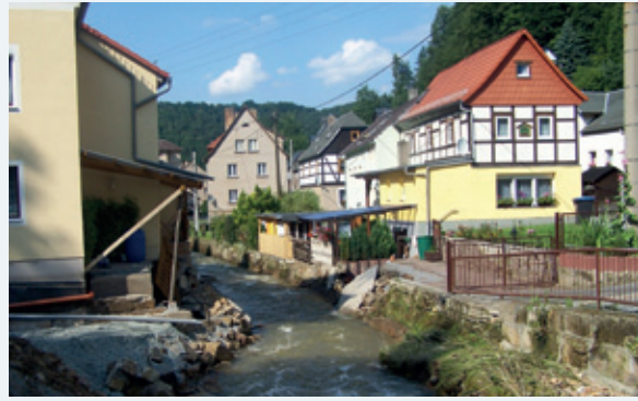
Abbildung 9-78: Nach dem Hochwasser des Krippenbachs, 10.08.2010 (Foto: LTV)
