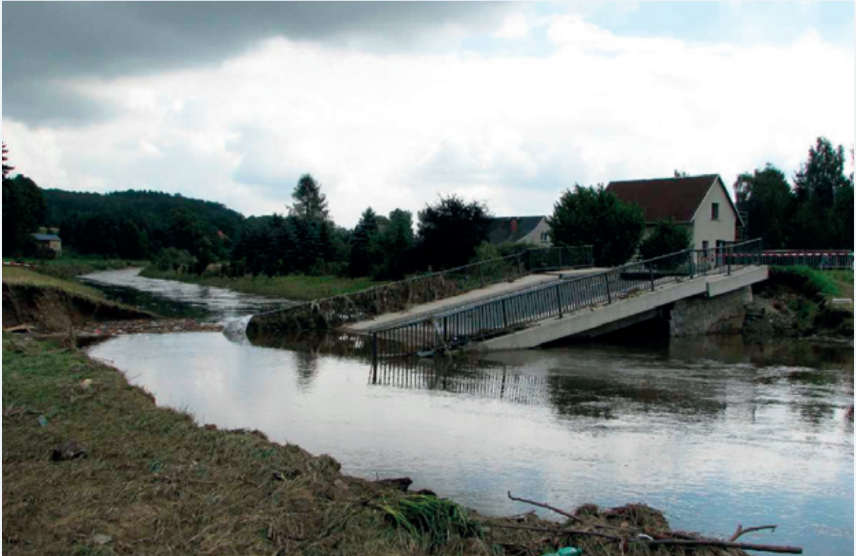
Abbildung 9-48: Zerstörte Brücke (Foto: Hr. Baldauf)
