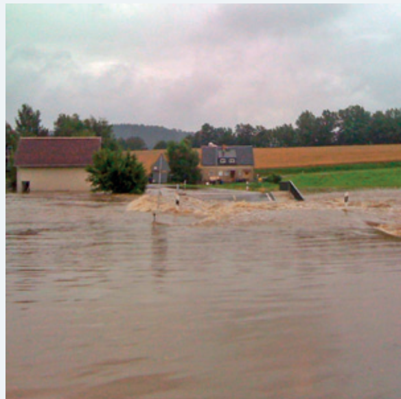
Abbildung 9-47: Zerstörung (Foto: Hr. Baldauf)
