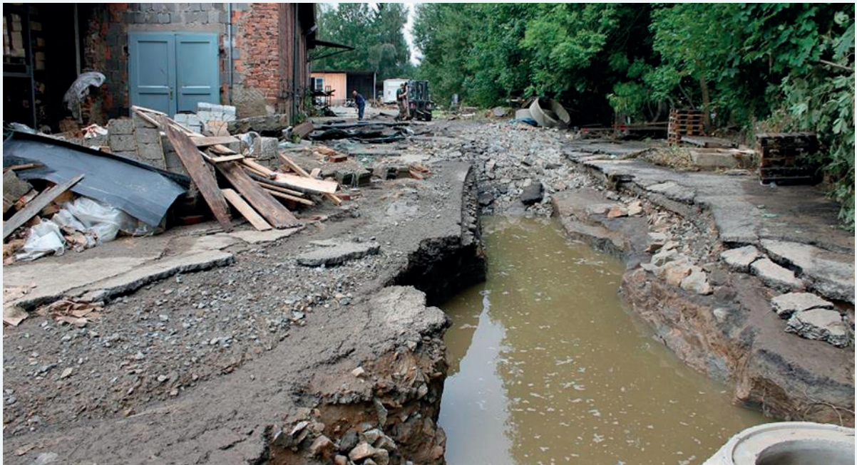
Abbildung 6-11: Starke Erosionserscheinungen in Weigsdorf-Köblitz (Foto: Gemeinde Cunewalde)
