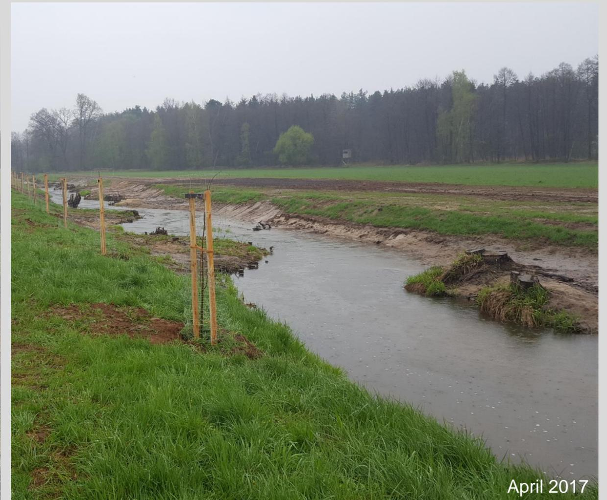
Trichterbuhne – Strömung wird an dieser Stelle zentriert und erhöht
