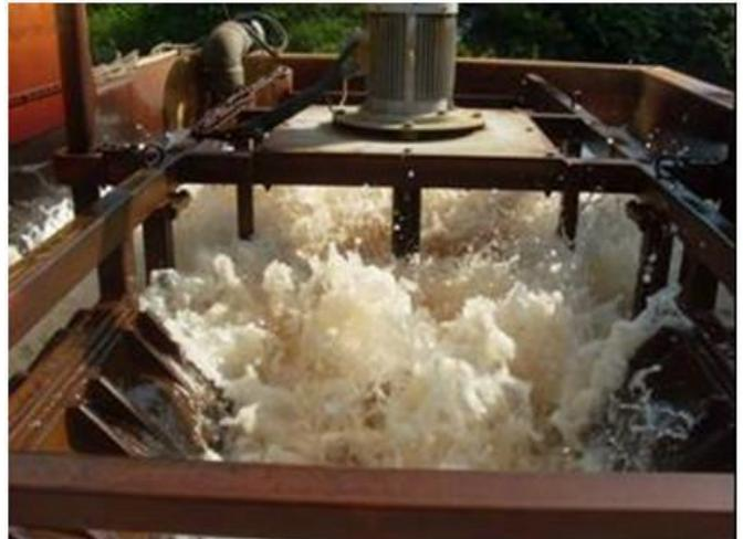
**Abbildung 15: Oberflächenbelüfter in einer WBA (Foto GEOS)**
