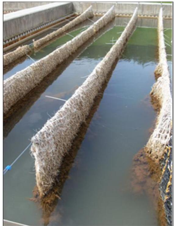
Abbildung 9: Abtrennung von Eisen in einem aeroben Becken mit Geotextilmatten (Foto GEOS)
