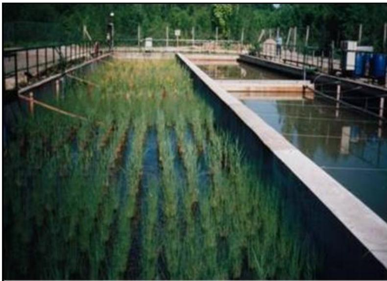
**Abbildung 12: Wetland zur Behandlung von Bergbauwasser, Abtrennung von Eisen, Mangan, Arsen und Radium (Foto GEOS)**
