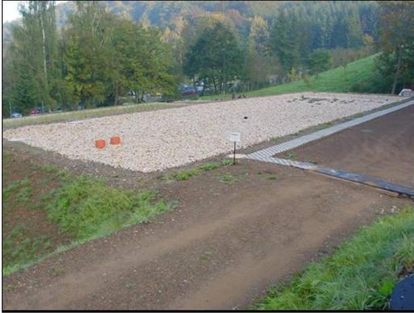
**Abbildung 11: Anaerobe Reduktionskammer zur Abtrennung von Schwermetallen durch Sulfatreduktion [BMBF 2001] (Foto GEOS)**
