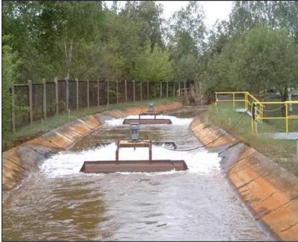
**Abbildung 14: Oberflächenbelüfter in dem Wasserzufluss (Westrandgraben) zu einer WBA (Foto GEOS)**
