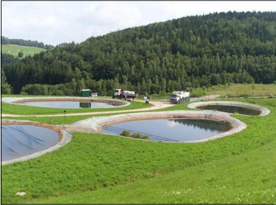
**Abbildung 10: Zweistraßiges Wetland zur Abtrennung von Fe, Mn, As und Ra (Foto GEOS)**
