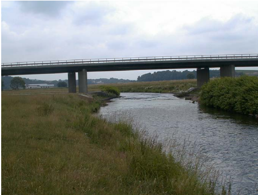
Abbildung 2: B km 65 + 739 (Nr. 34), Straßenbrücke B175 uh. Glauchau (neuer Verlauf)
