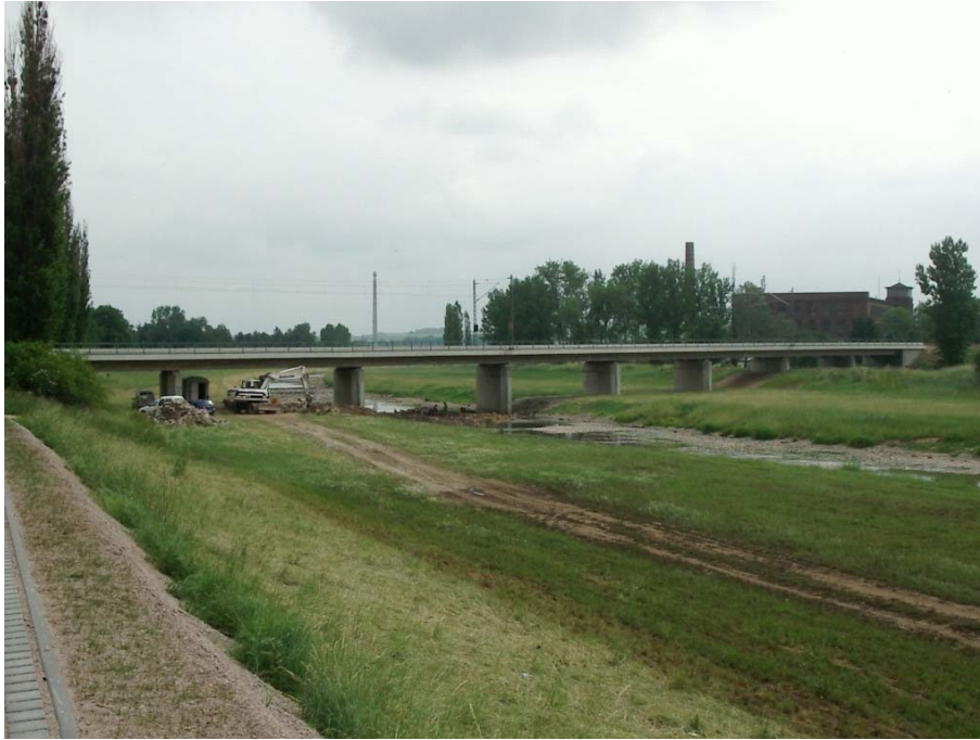
Abbildung 4: B km 1 + 032 (Nr. 36), Eisenbahnbrücke über Flutmulde in Glauchau
