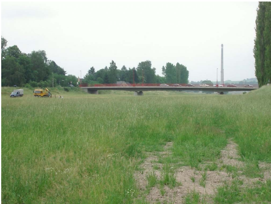
Abbildung 3: B km 0 + 465 (Nr. 35), Straßenbrücke über Flutmulde in Glauchau.
