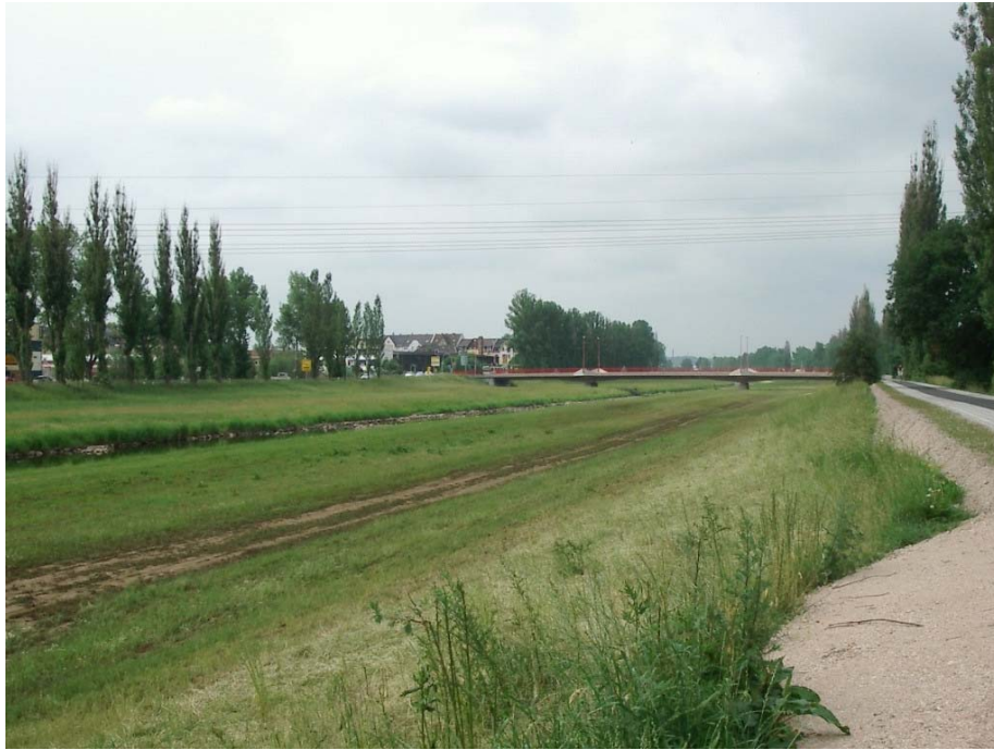
Abbildung 5: B km 1 + 455 (Nr. 37), Straßenbrücke S288 über Flutmulde in Glauchau
