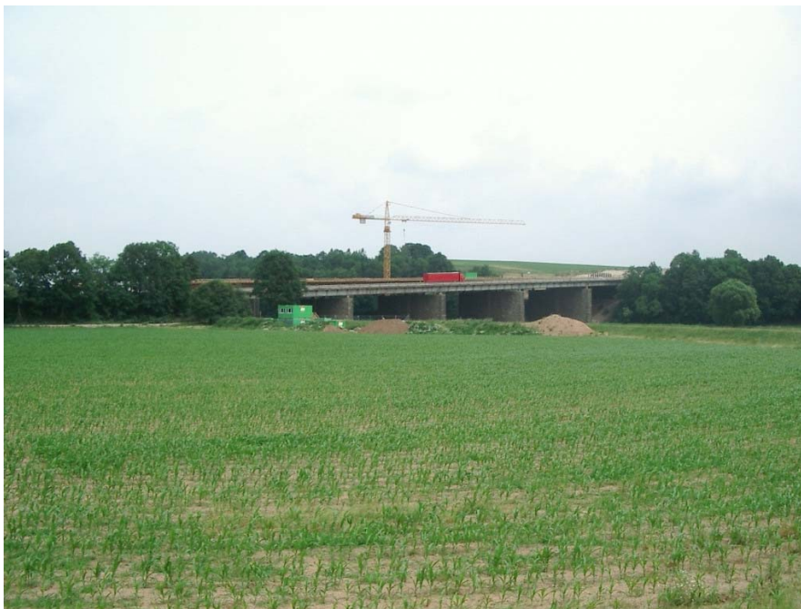
Abbildung 1: B km 64 + 087 (Nr. 33), Straßenbrücke BAB4 unterhalb Glauchau
