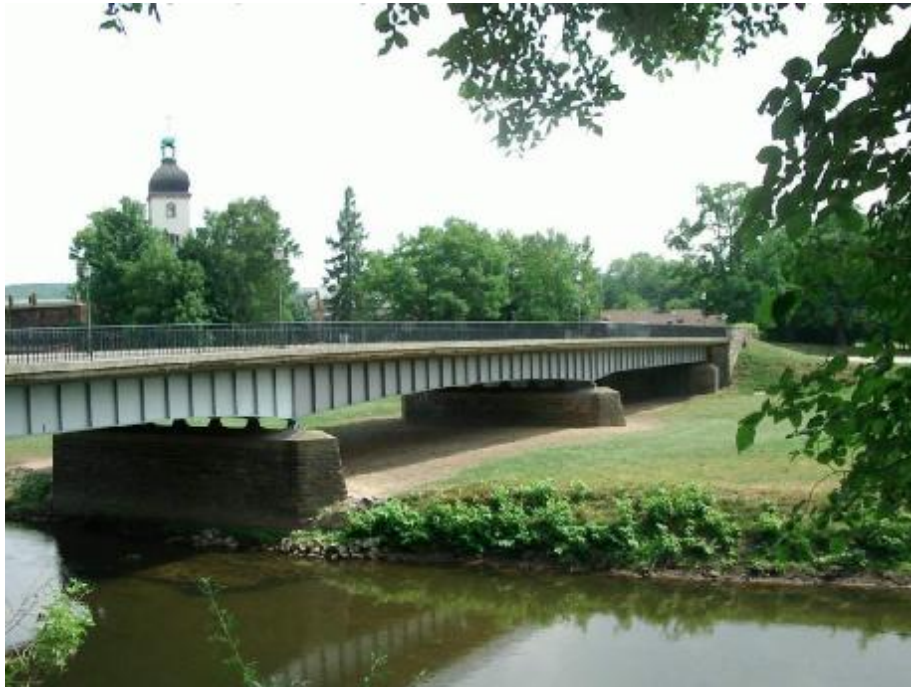
Abbildung 1: B km 57 + 345 (Nr. 28), Straßenbrücke B180 in Waldenburg
