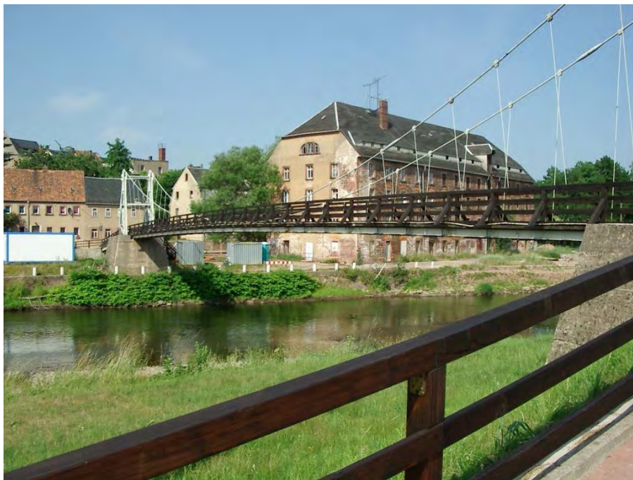
Abbildung 4: B km 19 + 240 (Nr. 6), Fußgängerbrücke in Rochlitz
