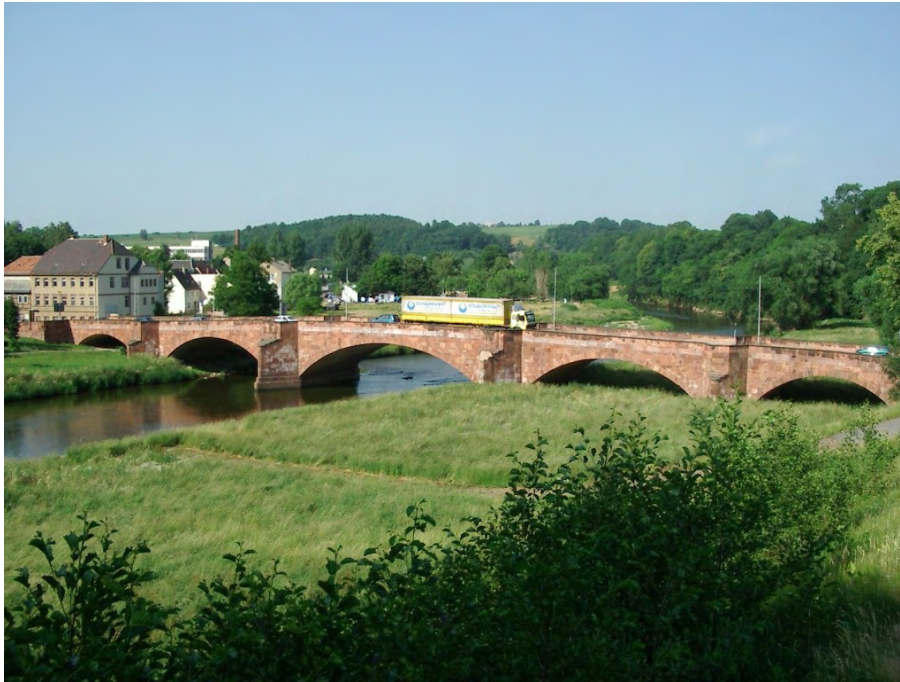
Abbildung 2: B km 18 + 266 (Nr. 5), Straßenbrücke B 107/ B 175 in Rochlitz
