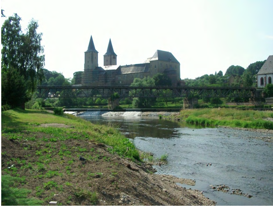
Abbildung 5: B km 19 + 428 (Nr. 7), Eisenbahnbrücke in Rochlitz
