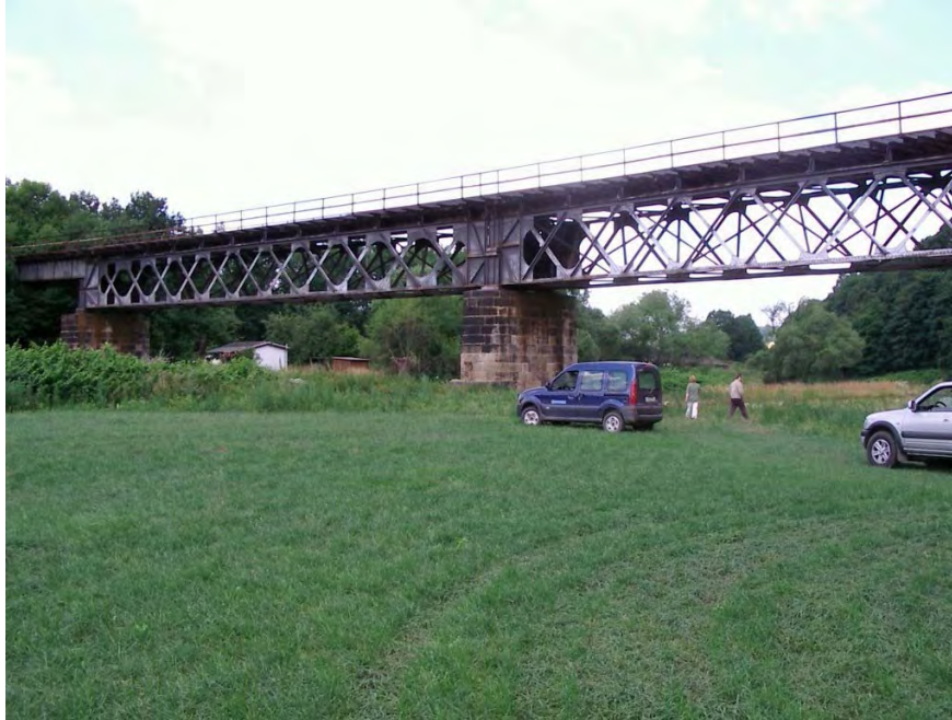
Abbildung 1: B km 15 + 847 (Nr. 4), Eisenbahnbrücke unterhalb Rochlitz
