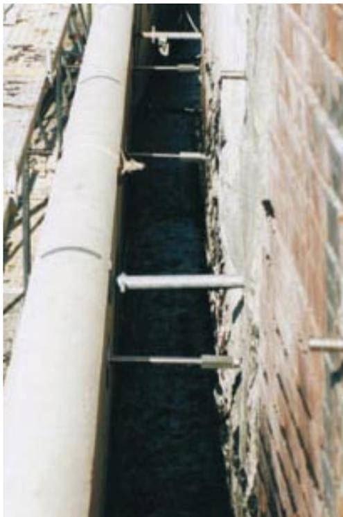
Der Asphaltbeton als Dichtungsschicht hatte die für den Asphaltwasserbau typischen Qualitätskriterien zu erfüllen. Beim manuellen Einbau des Asphaltbetons mit Elektrostampfern wurde besonders auf die ausreichende und gleichverteilte Verdichtungsarbeit, die Einhaltung des Temperaturregimes und die projektgemäße Umhüllung der Anker mit Bindemittel geachtet.
