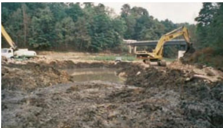
◀ Abbildung 12: TS Bautzen, Sedimentberäumung der Vorsperre
