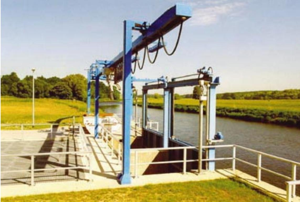
▲ Einlaufbauwerk mit automatischer Rechenreinigungsanlage
