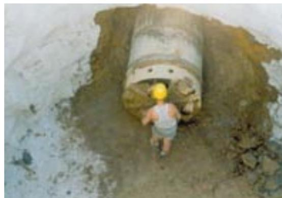
▲ Abbildung 15: Rohwasserüberleitung, Start- und Zielschacht
