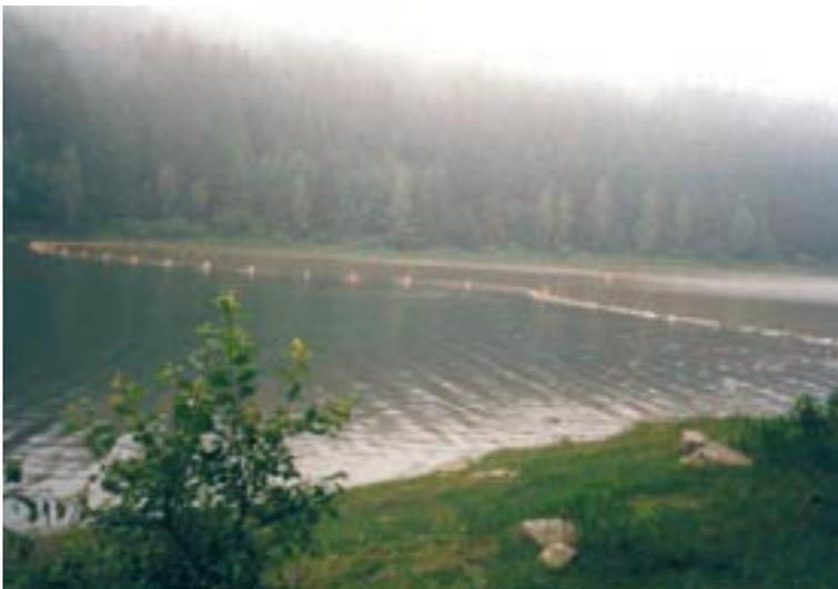
Begleitung der TU Dresden im Bereich der Unterwasservorsperre Haselbach eine Folientauchwand errichtet. Das von der 160 m langen und 7,3 m tiefen Tauchwand abgetrennte Wasservolumen beträgt ca. 370.000 m<sup>3</sup> und hat eine Oberfläche von ca. 7 ha.
