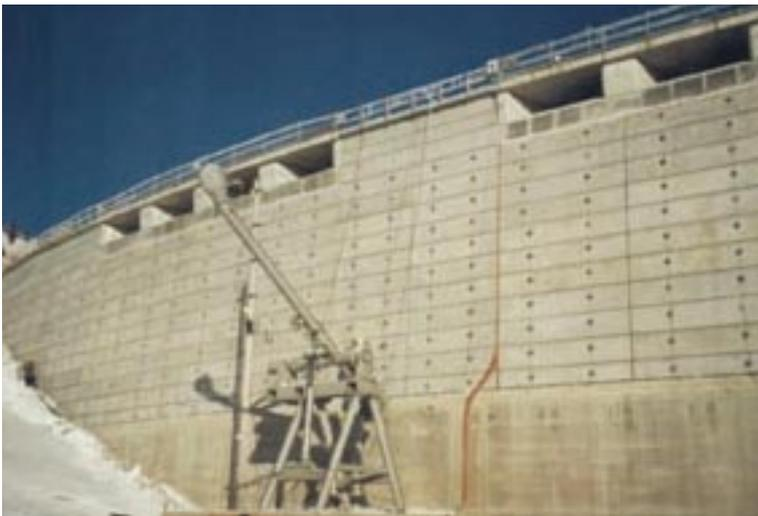
◀ Abbildung 6: TS Carlsfeld, wasserseitiger Schutzmantel aus Fertigteilen mit Provaranlage
