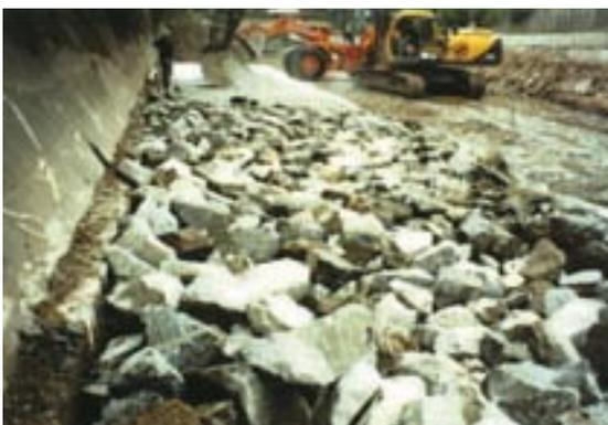
◀ Deckschicht Sohlbefestigung <sup>3</sup>
