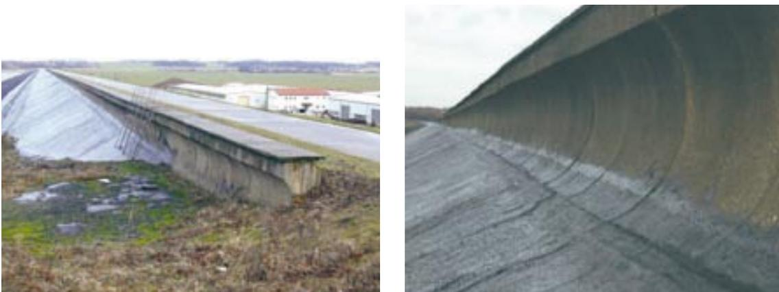
▲ Bild 10: Wellenumlenker an der Krone des Nord-Ost-Dammes der Talsperre Bautzen vor der Sanierung (31.01.2000)
