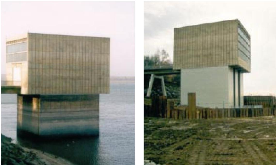
▲ Abbildung 11: TS Bautzen, Entnahmeturmschaft vor und nach der Beschichtung
