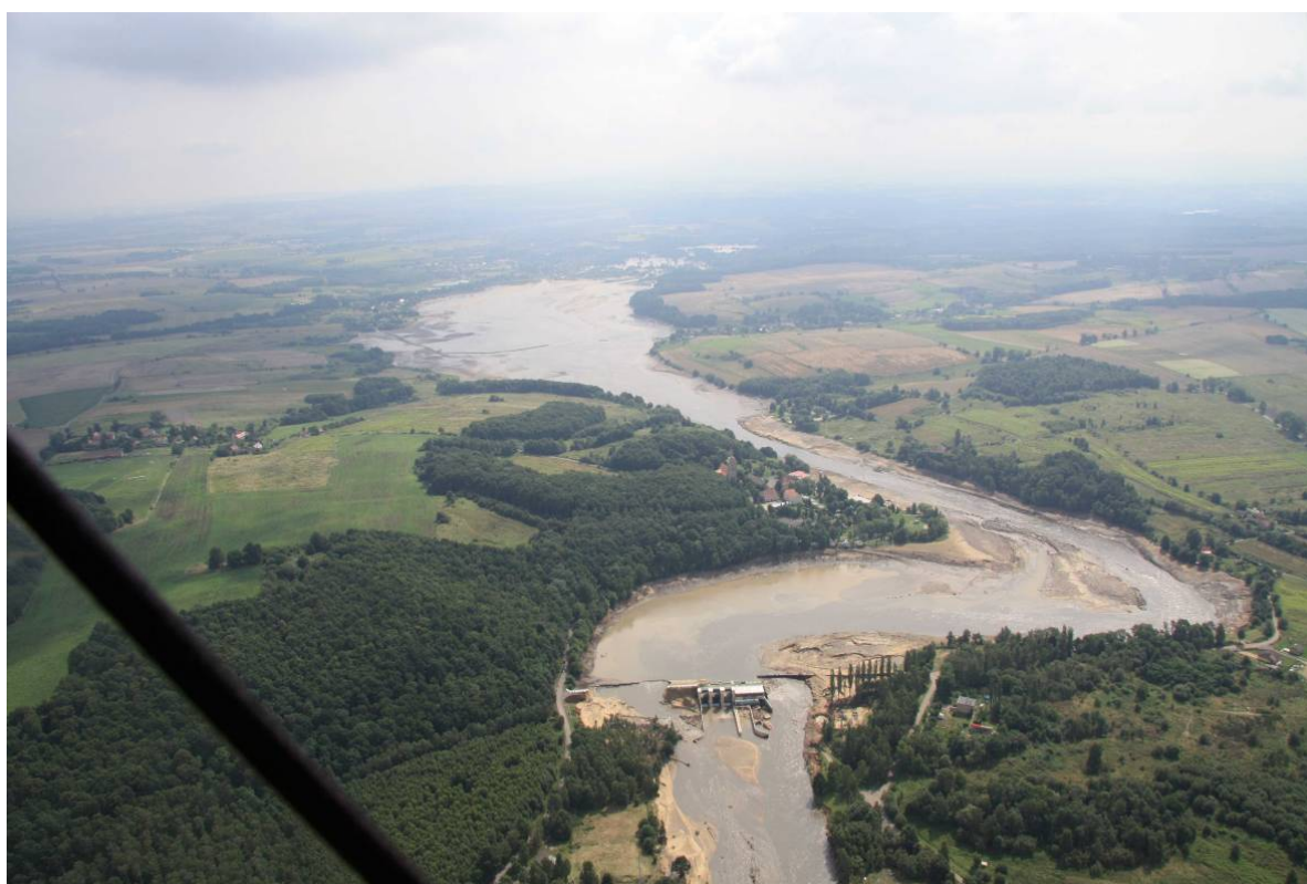
Rys. 15: Przerwana zapora na zbiorniku wodnym Niedów i dolina Witki w dniu 08.08.2010 (Zdjęcie: SMI)
