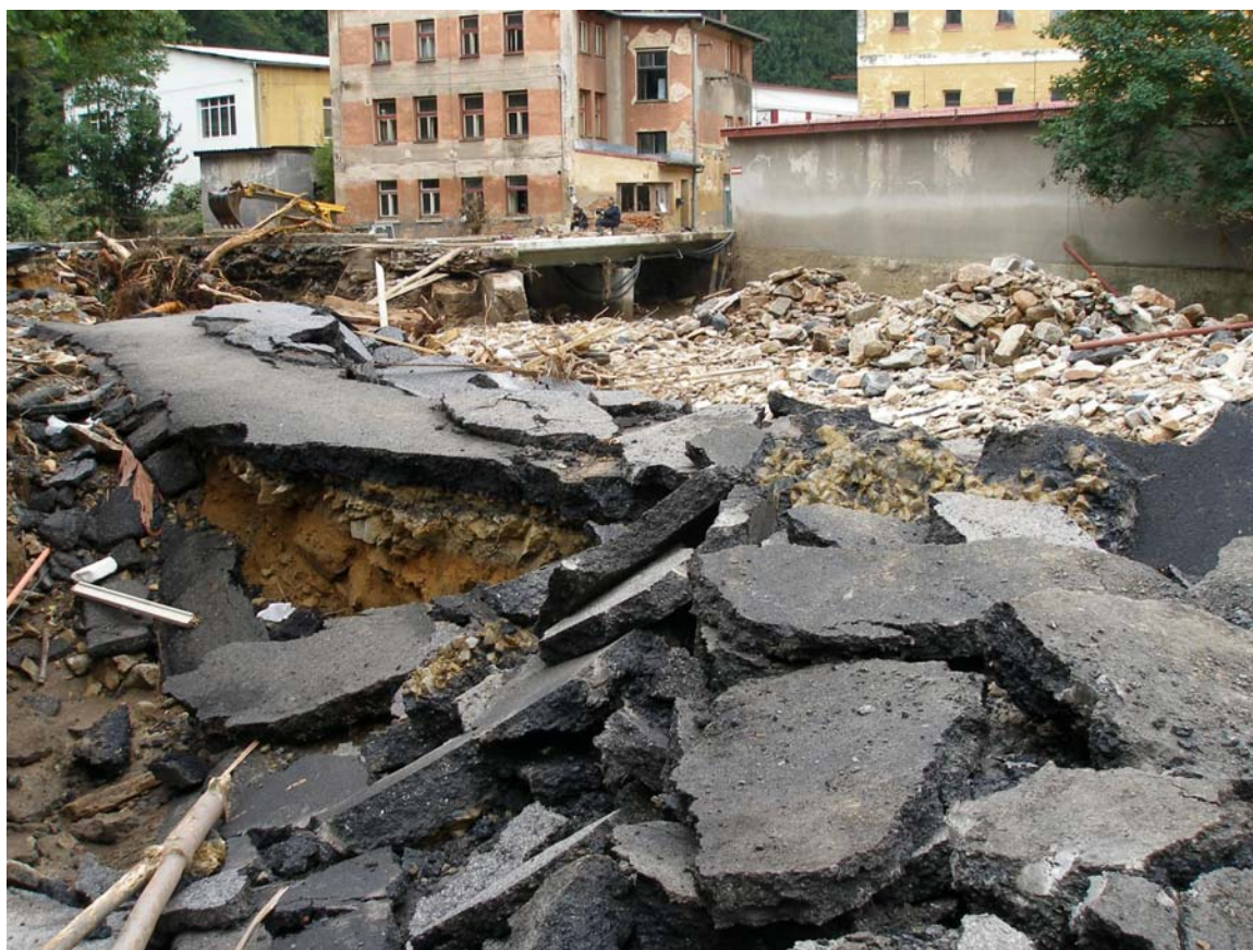
Rys. 11: Szkody spowodowane przez rzekę Směda w miejscowości Frýdlant (Zdjęcie: Povodi Labe z dnia 13.8.2010)
