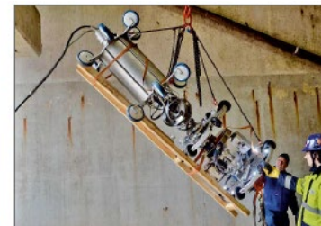
Hinablassen des SLOFEC® Scanners im Düker-Unterhaupt.
